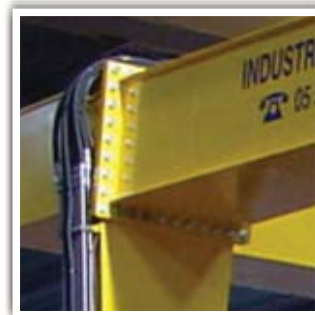
STRUCTURE AVEC ASSEMBLAGE VISSÉ FACILITANT LE DÉMONTAGE
