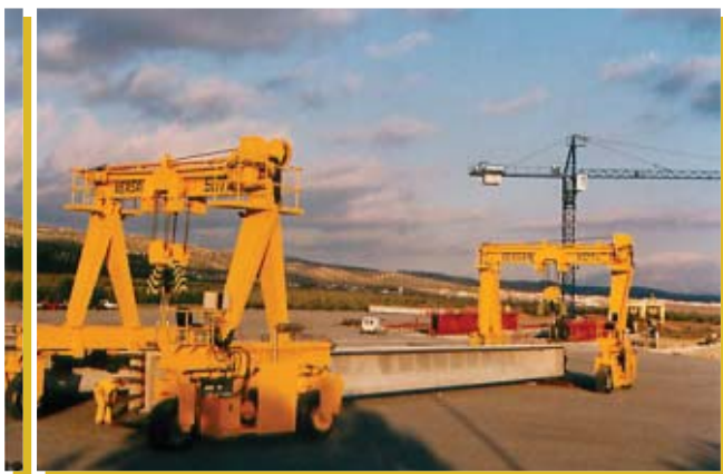
MANUTENTION DE POUTRES EN BETON
