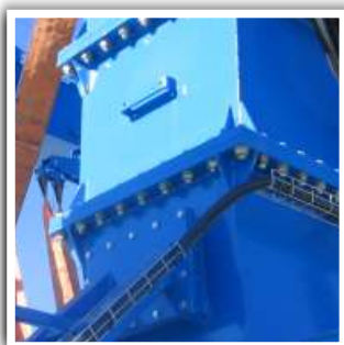
STRUCTURE AVEC ASSEMBLAGE VISSÉ FACILITANT LE DÉMONTAGE
