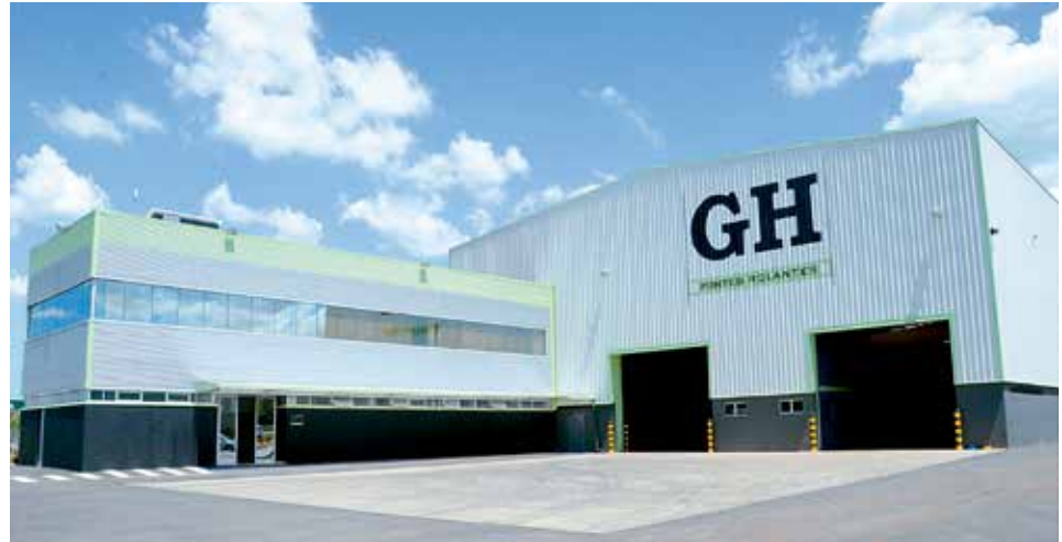
Instalaciones de GH en Cabreúva.
